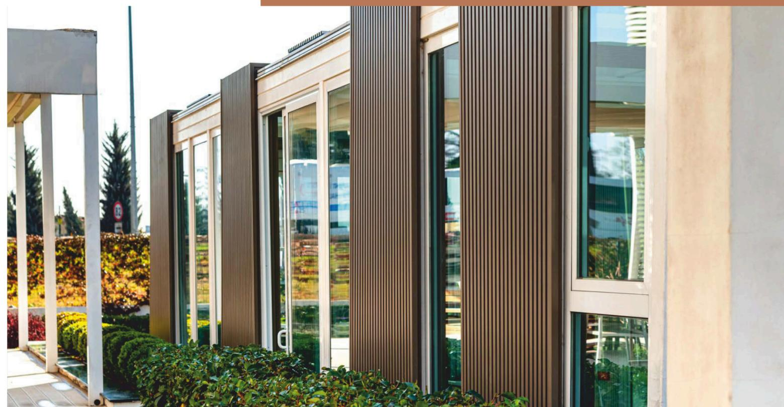
Si tratta di profili in policloruro di vinile non plastificato (cosiddetto PVC-U) a base di polimeri di alta qualità appositamente progettati e rivestiti con una membrana brevettata, sia per esterni che per interni, in base ad una tecnologia superiore che li rende resistenti all'acqua, estremamente resistenti agli urti e ai raggi del sole.
